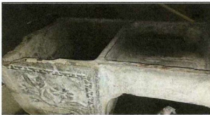
Foto 4: Se observa la pila de la cocina en mal estado.
